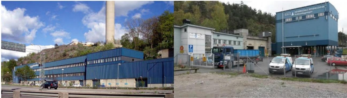
Figur 2 Henriksdalsanläggningen och Sicklaanläggningen
