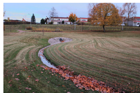
Ovan och nedan exempel på större överdämningsytor/torra dammar med ut- och inlopp via ett dike.
