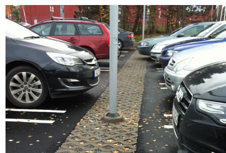
Makadamdike på parkeringsplats där ett raster av betong lagts i överytan.
