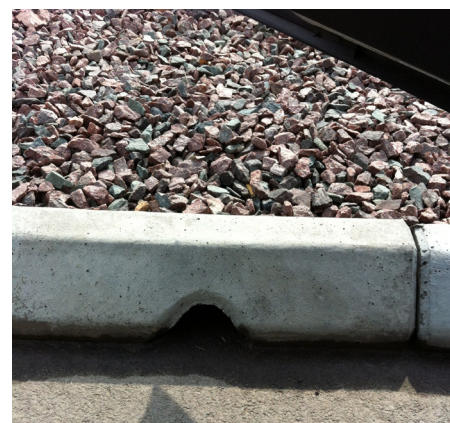
Inlopp till makadamdike genom hål i kantsten.
