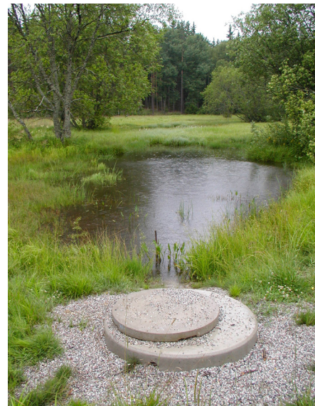
Dammutlopp via en munkbrunn. Vattennivån kan regleras och vatten ledas ut under ytan så att flytande föroreningar kan hållas kvar i dammen.
